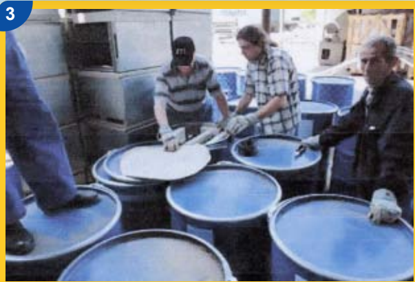
Die Fässer in welchen die PCB-haltigen Stoffe verpackt sind, werden verschlossen.
