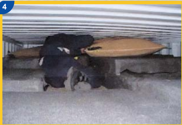
Die PCB-haltigen Abfälle werden im Container transportgesichert.
